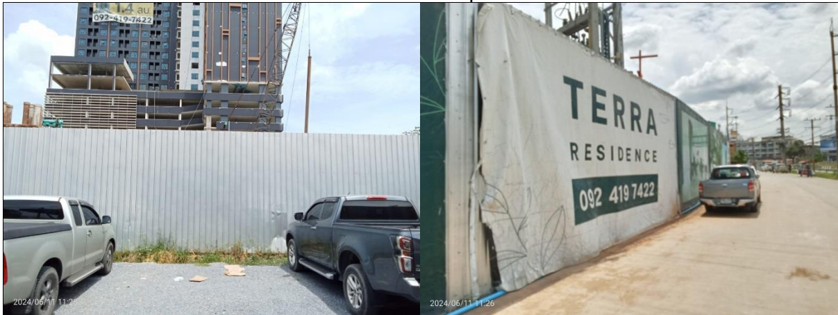
รูปที่ 2-1 รั้ว Metal Sheet ความสูง 4 เมตร รอบแนวเขตพื้นที่โครงการ
